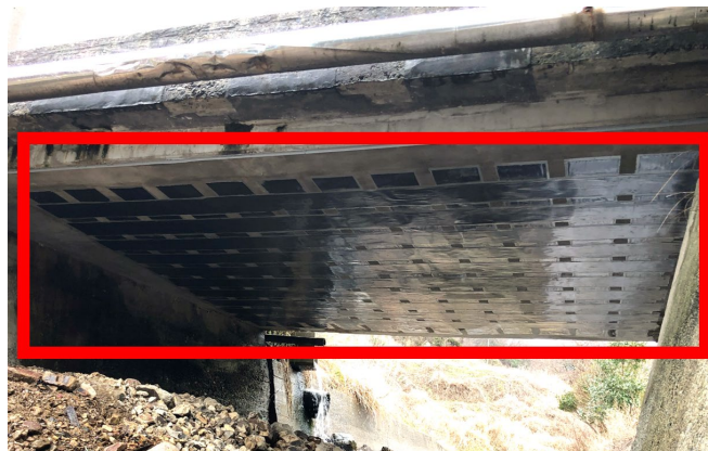
APLASシート工法による補強工事後の山田橋。 橋軸に対して、水平と直角の2方向の格子状に APLASシートを貼り付けて補強
