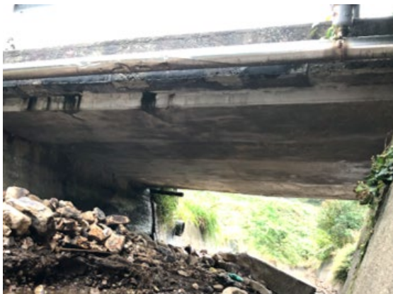
補強工事前の山田橋
